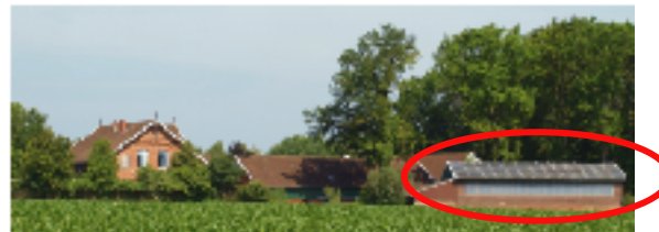
Solaranlage bindet sich harmonisch ins Erscheinungsbild ein.
