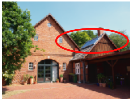
Solaranlage in deutlich untergeordneter Anbringung
