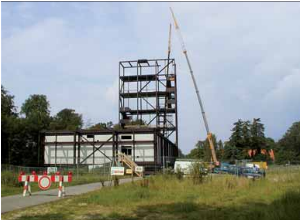
Museum und Park Kalkriese im Rohbau
