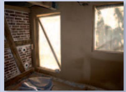
*Oben: Verbesserung eines Fachwerkgebäudes durch den Einbau einer Holzweichfaserplatte mit Wandflächenheizung und Lehmputz; unten: Einbau eines Innenfensters in der Dämmebene; Erhalt des historischen Fensters*
