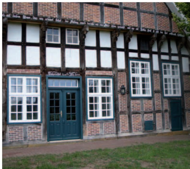
*Sanierter Wohngiebel; Einbau von Doppelfenstern, Reparatur Fachwerk, Erhalt der historischen Tür*
