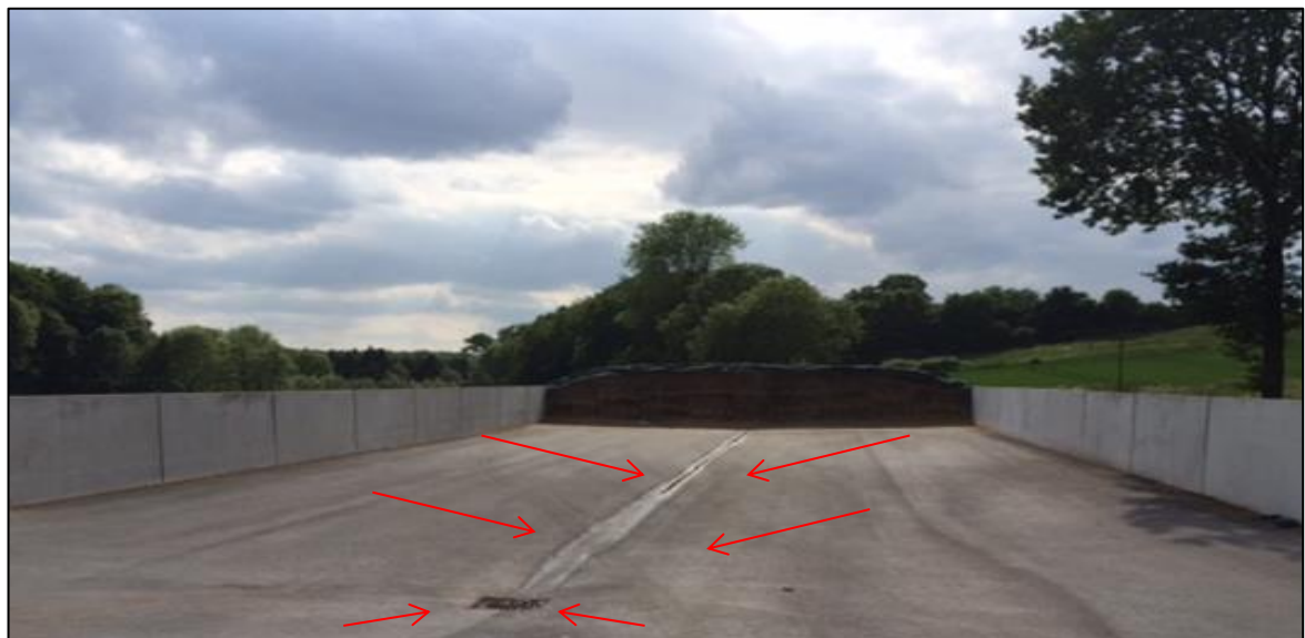
Abbildung 1: Entwässerung von Silagelagerungen
