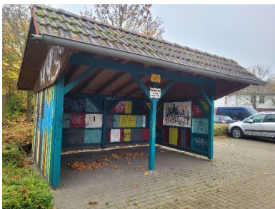
Abbildung 32: Wettergeschützter Wartebereich am Parkplatz. Quelle: GreenAdapt, 2024.
