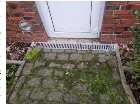
Abbildung 34: Entwässerungsrinne vor Tür. Quelle: GreenAdapt, 2024.
