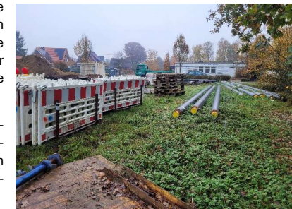
Abbildung 29: Nördlich angrenzende Brachfläche mit Baustelleneinrichtung. Quelle: GreenAdapt, 2024.
