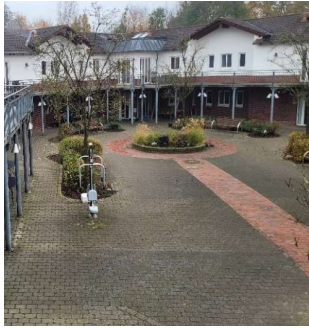
Abbildung 30: Gepflasterter Innenhof. Quelle: GreenAdapt, 2024.
