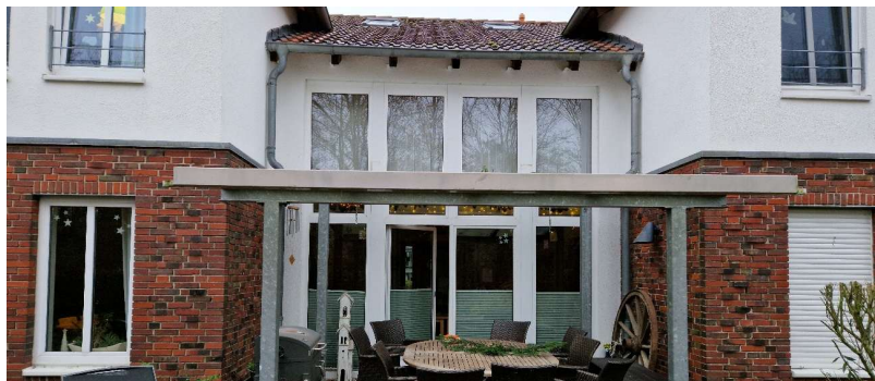
Abbildung 14: Nicht verschattete Pfosten-Riegel-Konstruktion im Bereich der Wohndiele. Quelle: ÖkoZentrum, 2024.
