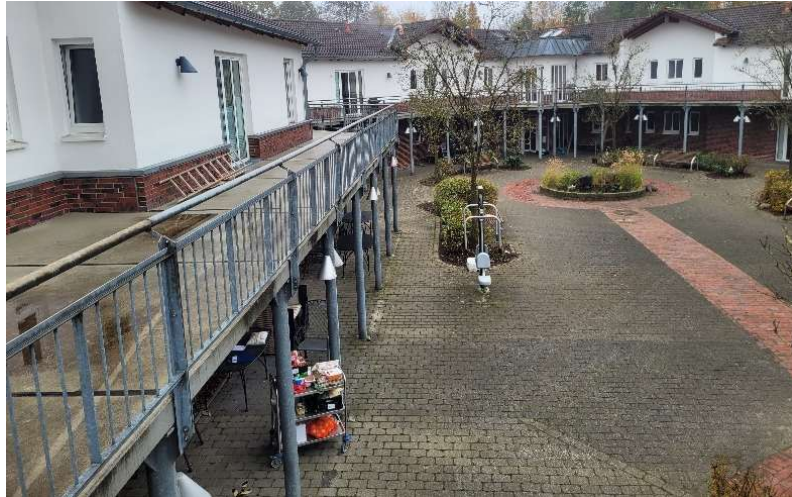
Abbildung 9: Bauliche Verschattung im Innenhofbereich. Quelle: GreenAdapt, 2024.
