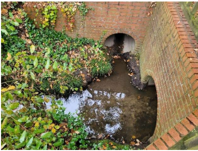
Abbildung 25: Der Bokeler Bach im Bereich der Unterführung unter der Franz-Hecker-Straße. Quelle: GreenAdapt, 2024.
