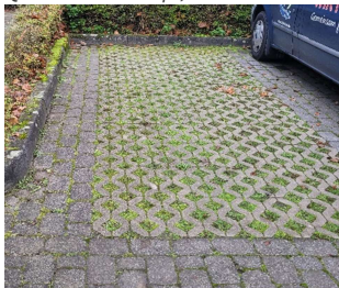
Abbildung 31: Rasengittersteine am Parkplatz. Quelle: GreenAdapt, 2024.
