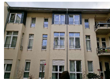
Abbildung 12: Die Fenster im Innenhof sind lediglich im EG mit Rollläden ausgestattet, Quelle: ÖZ, 2025.
