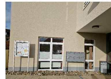
Abbildung 11: Der Raum "Büro PDL" zählt zu den kritischsten Räumen bzgl. Überhitzung, Quelle: ÖZ, 2025.
