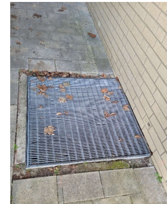
Abbildung 29: Kellergitter vor dem straßenseitigen Eingang (Ostseite). Quelle: GreenAdapt, 2024.
