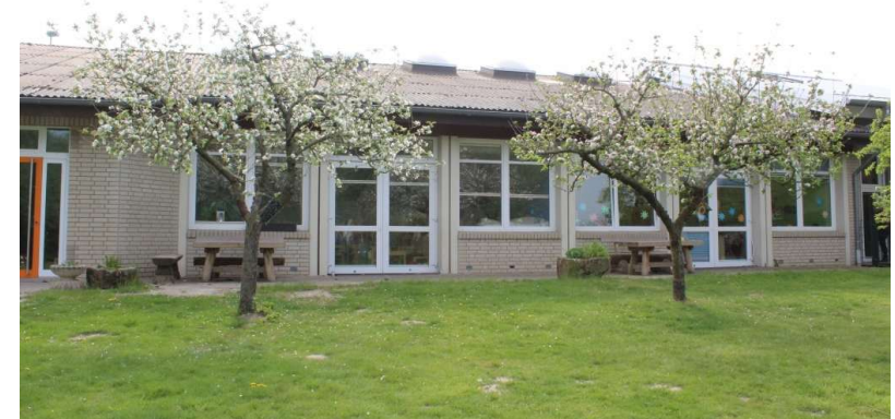
Abbildung 2: Außenbereich der KiTa. Quelle: GreenAdapt, 2024.
