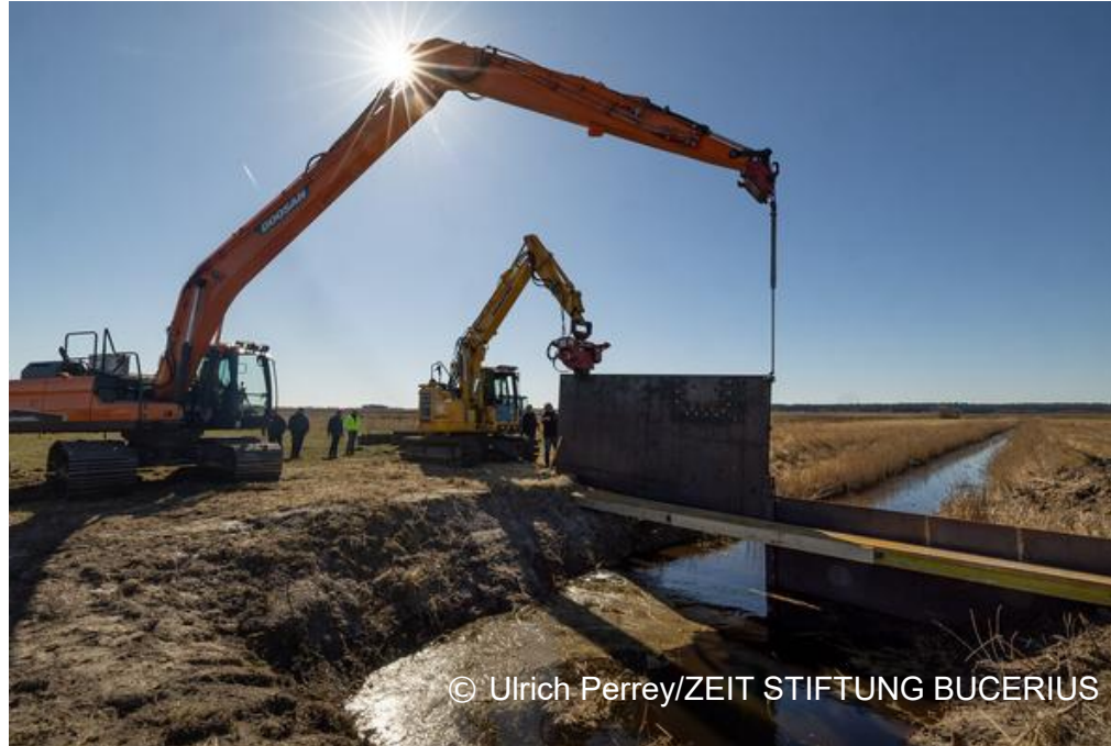
Setzen von Kippweren, DBU-Naturerbfläche Peenemünde
