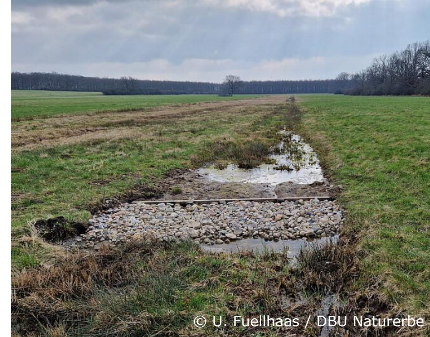
Grabenplomben und Sohlgleiten regulieren den Wasserdurchlauf, DBU-Naturerbfläche Wohlder Wiesen
