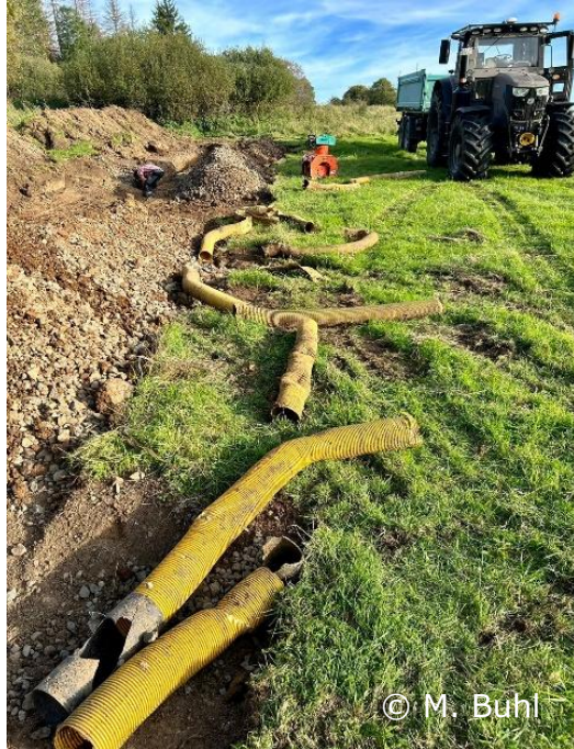
Entfernung von Drainagen, DBU-Naturerbfläche Stegskopf
