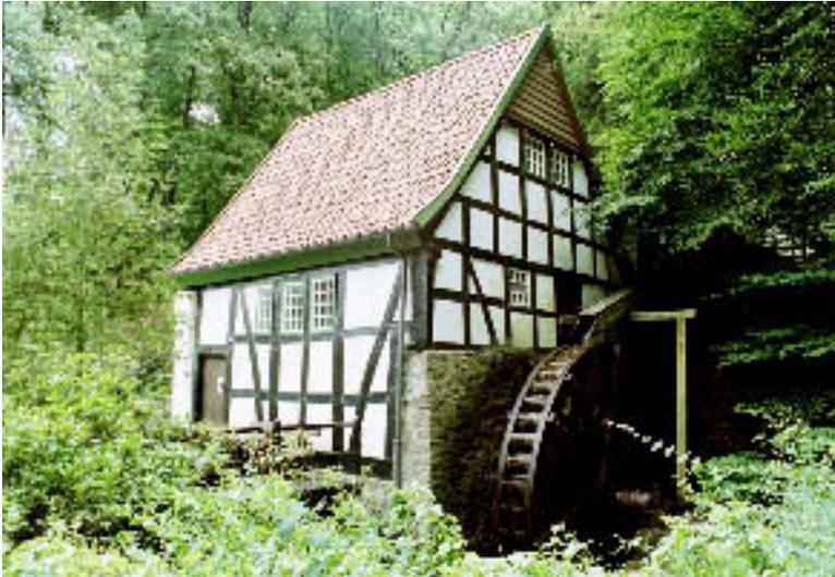
Die Wassermühle in Bad Essen wurde 1359 erstmals erwähnt. Der heutige Wandständerbau von 1780 ist auf einem Bruchsteinmauerwerk errichtet, das zum Mühlenreich bis zu 80 Zentimeter stark ist.
